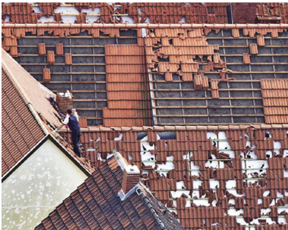
Bei Hagel können Dachziegel und Dachfenster brechen.
